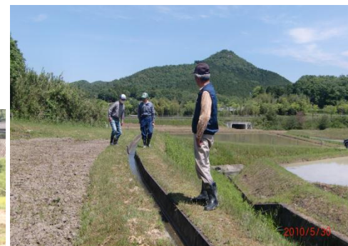
☞ 役員が、農地・水路・農道の状態を点検(5月30日)
